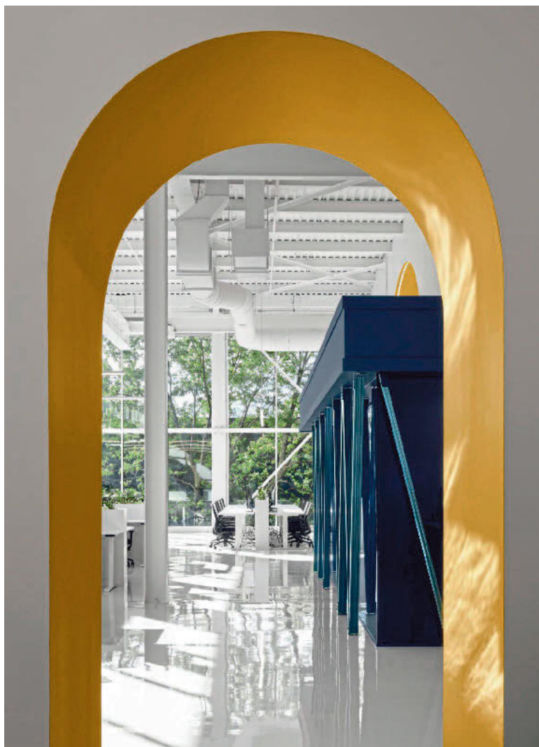
Die Hallenfläche und -höhe sahen die Planer als Herausforderung und strukturierten den Raum mit Einbauten.
