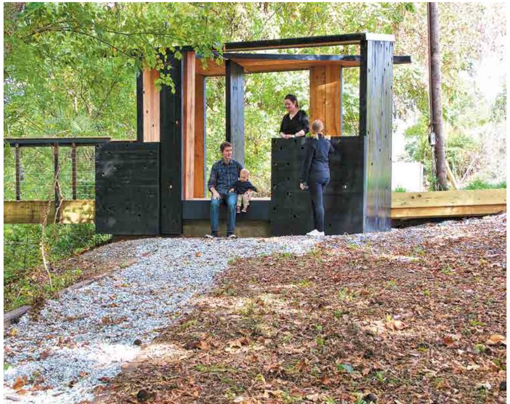
Cada orifício do parafuso foi impregnado com cera líquida e, em seguida, todo o envelope externo foi revestido com uma mistura de óleo de linhaça e alcatrão de pinho natural para protegê-lo dos danos causados pelos raios UV, calor e umidade
