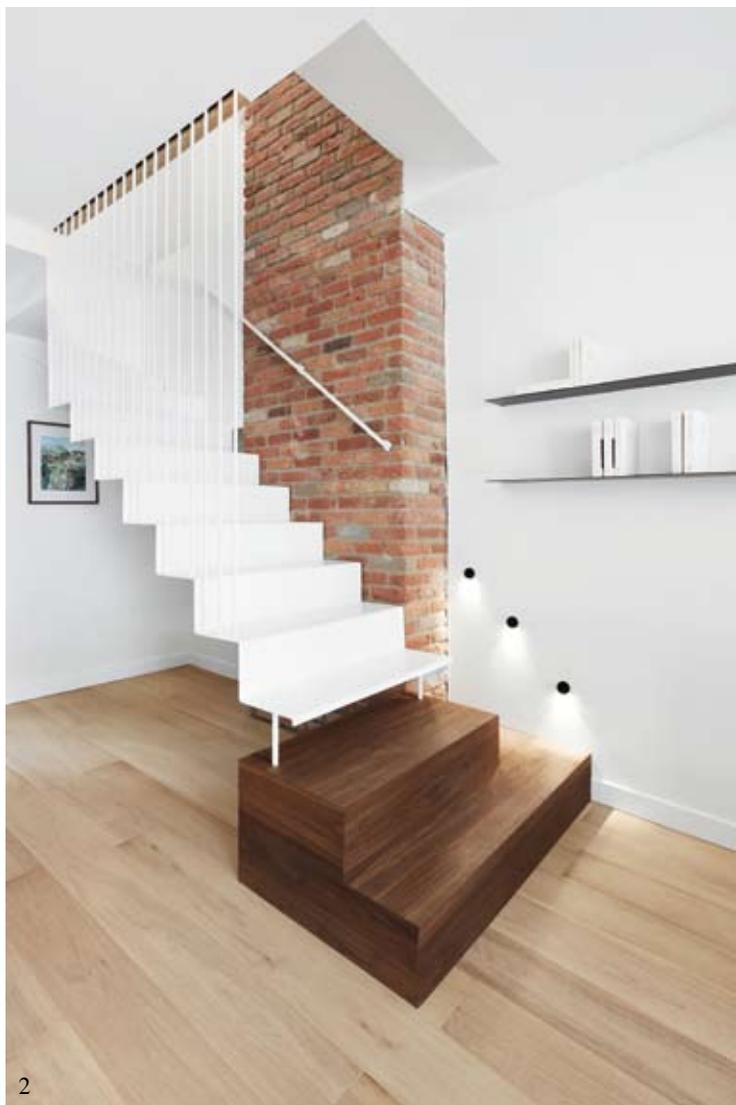
1/ 樓梯由折疊的金屬板構成，並以纖幼的懸掛鋼筋鞏固結構。
