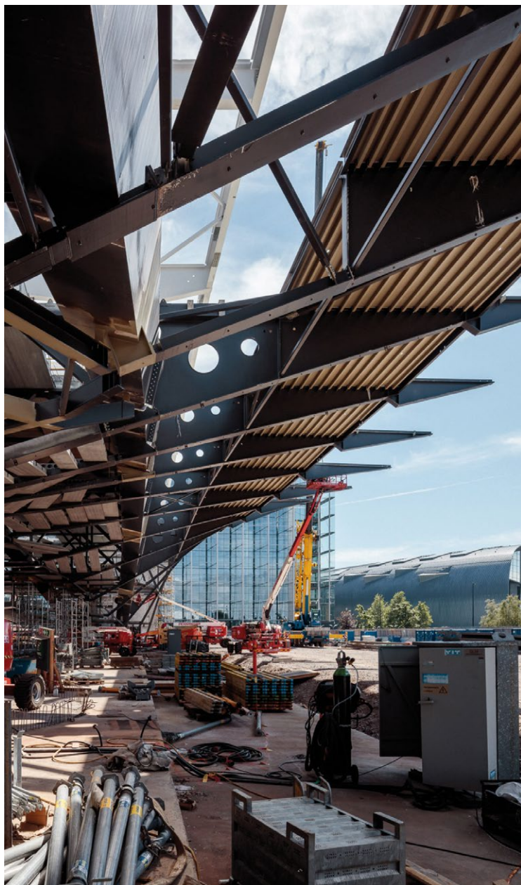
ΔΕΥΤΕΡΕΥΟΥΣΕΣ ΜΕΤΑΛΛΙΚΕΣ ΔΟΚΟΙ ΥΠΟΣΤΗΡΙΖΟΥΝ ΤΟΝ ΠΡΟΒΟΛΟ ΚΑΙ ΤΟ ΣΤΕΓΑΣΤΡΟ.
