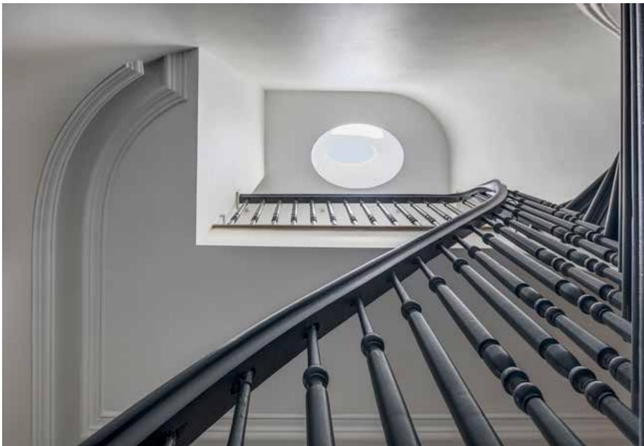
*Dans la cage d'escalier joliment ornée de moulures et d'une rampe restaurée, Alexandra Barker troque la vieille fenêtre de toit pour un nouveau modèle de forme ovale pour s'accorder à celle des murs.*
