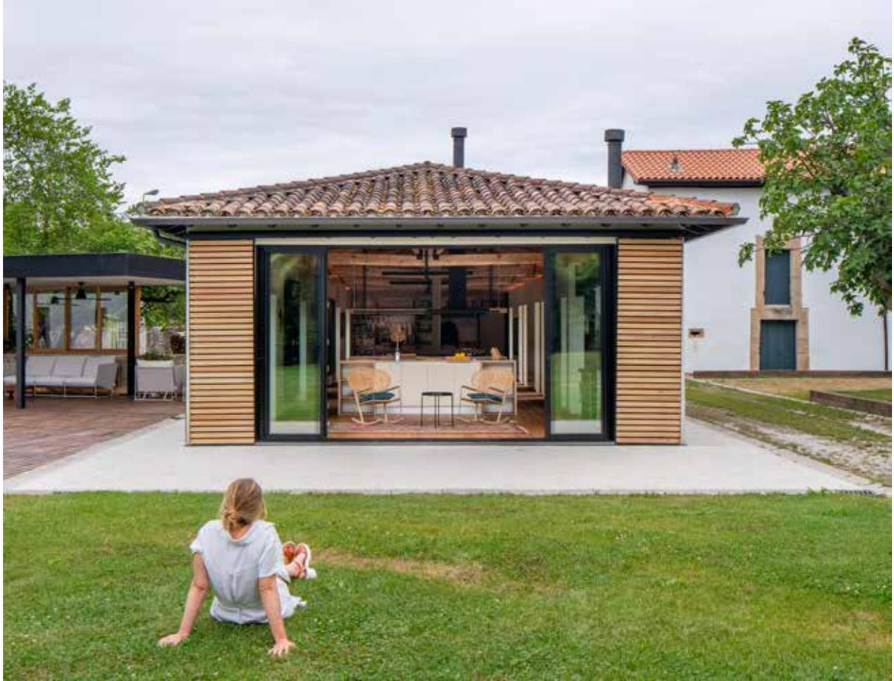
*En trop mauvais état, certains murs de la grange ont dû être démolis comme son pignon sud, remplacé par une grande baie coulissante encastrée dans une structure métallique. Elle permet d'ouvrir généreusement l'espace à l'extrémité du bâtiment.*
