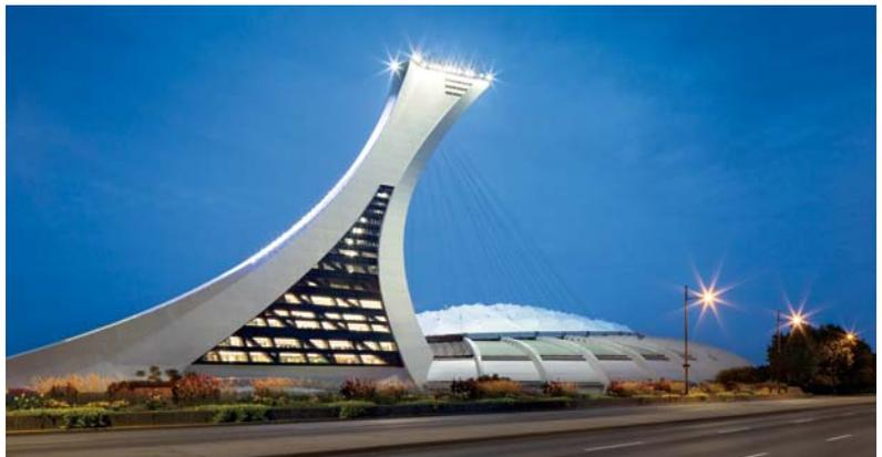
Durante los trabajos de renovación iniciados en 2015, Provencher\_Roy reemplazó la envoltura de hormigón prefabricado por una cortina/muro que ofreciera mayor transparencia, aumentando la presencia de luz natural y respetando a su vez la arquitectura original. Diseñada por el arquitecto Roger Taillibert, la torre original fue concebida para albergar federaciones deportivas, por lo que debió ser readaptada hacia una masiva actualización de estándares para expresar su nueva vocación corporativa.
